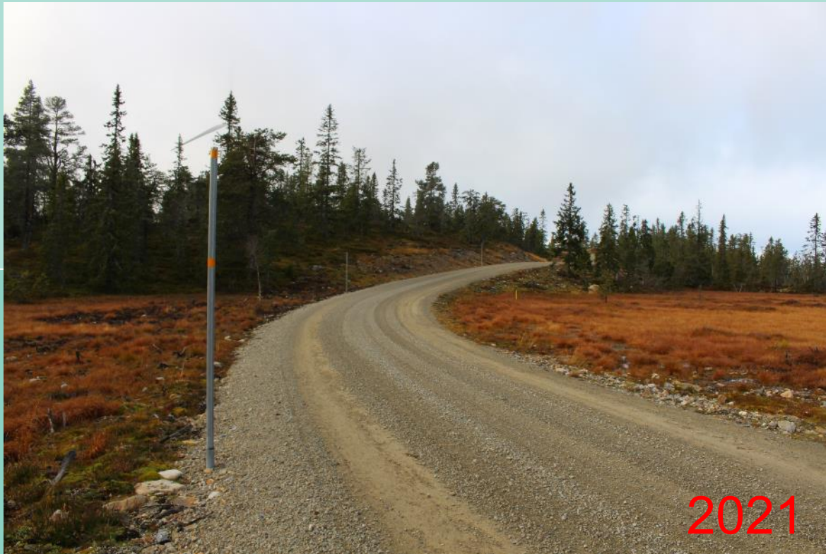
Myrkryssing - anleggsveg Raskiftet
